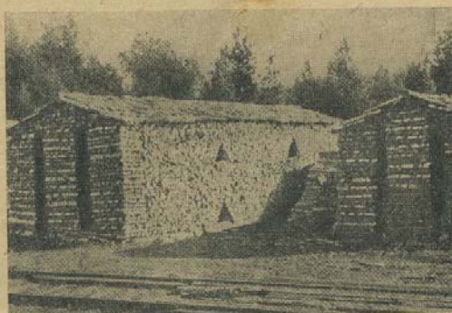
11. att. Malkas krautuve pie Somijas dzelzceļiem ar vēdināšanas kanāļiem.
